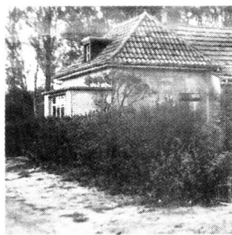
Das einzige noch existierende Trafo-Häuschen im Block D an der Adlerstraße Quelle Firtzlaff
