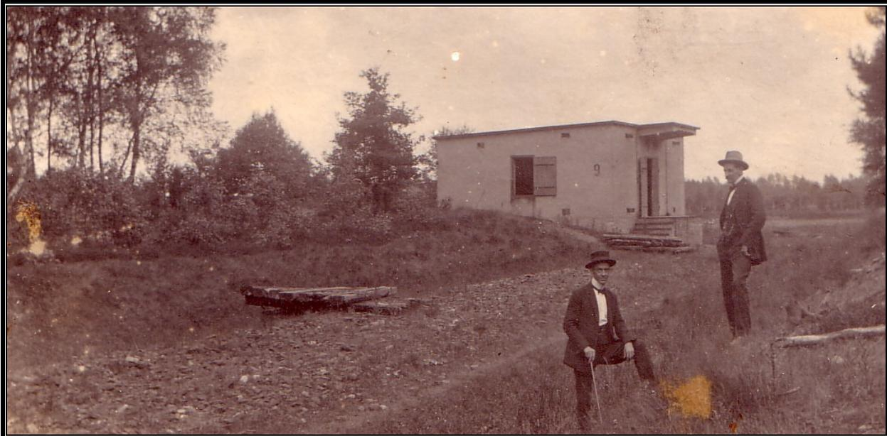
Die Aufnahme stammt aus dem Jahr 1926 oder 1927 und zeigt den Originalschuppen in D, Nr. 9. Gut zu erkennen ist der Schotter und die Schwellen für das Gleis, was nicht mehr gelegt wurde [Riese].
