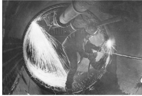
Die Schneidbrenner fressen sich durch die Dampfkesselwandung
