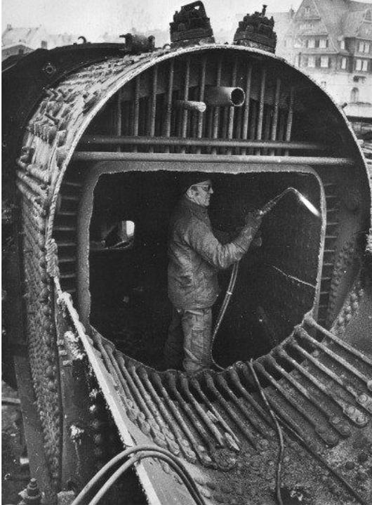
Der Arbeiter steht in der Feuerbüchse und schneidet weitere Stahlstücke aus dem Lokkessel heraus. Verschrottung einer 44er-Güterzug-Dampflok in den 1970er Jahren
