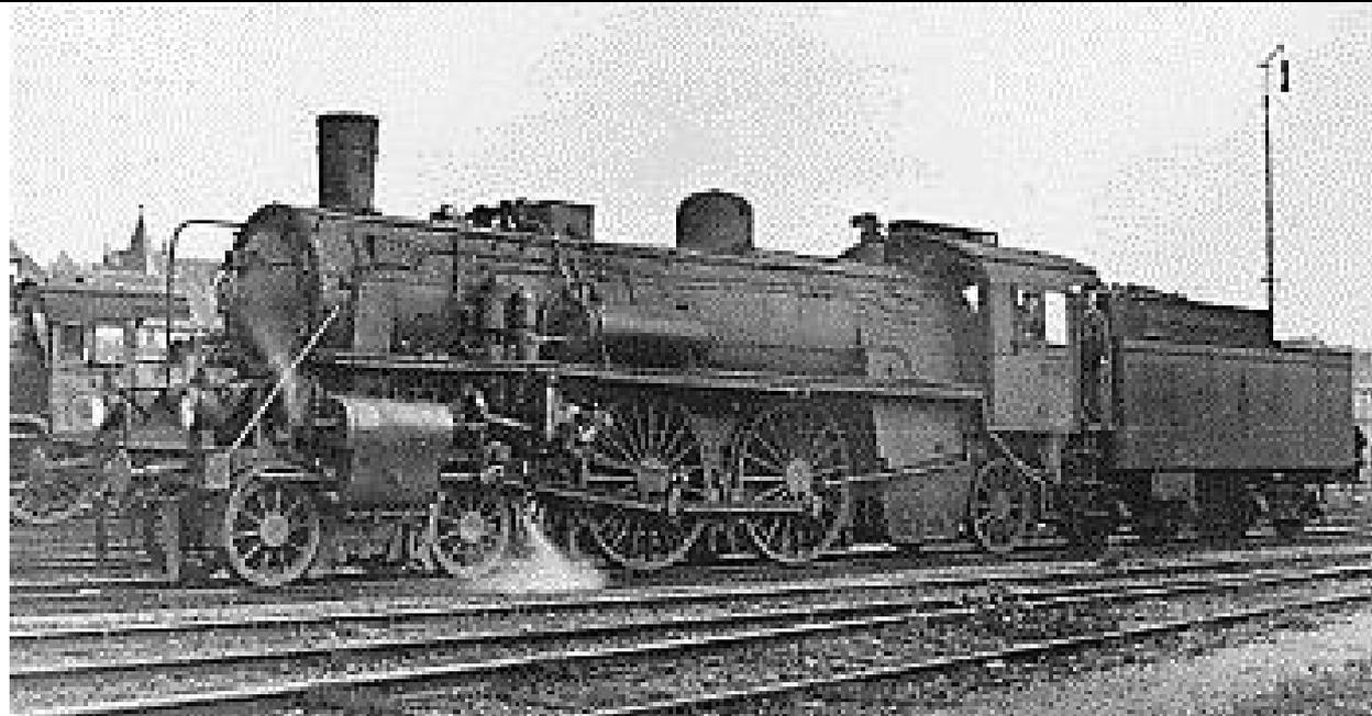
Vom technischen Fortschritt waren die Vierzylinder- Nassdampfverbund-Schnellzugloks der Gattung S9 überholt worden. Für den Betrieb unwirtschaftlich und zu teuer fanden sie schon nach wenigen Einsatzjahren den Weg zum Schrottverwerter. 1918 verfügte die KED Münster noch über 12 Loks dieser Gattung, die alle bis 1925 ausgemustert waren. Die S9-Loks waren die größten Maschinen, die im Depot Hembergen wohl zerlegt wurden
